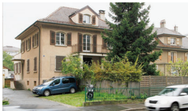
Trop vétuste, la cure devrait être démolie prochainement. SAMUEL FROMHOLD
